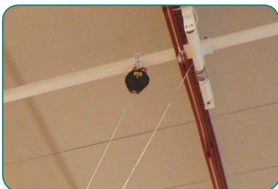
▲ Detalle del sistema de seguridad anti-caída y del mando a distancia incluido en las soluciones motorizadas. ▶
