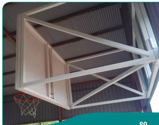
◀ Canasta de 1 m fijada directamente a pared de hormigón en posición de abatido.
